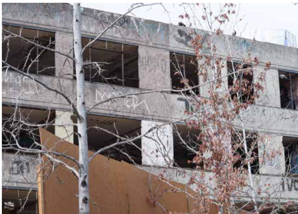
Foto 5. Bloques Villa San Luis en estado de semidemolición.
